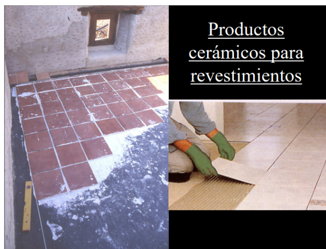
Imagen 20. Losa aplicada en suelos mediante materiales de agarre
