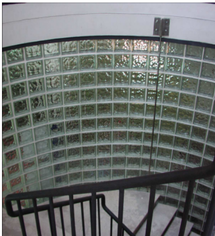
Imagen 46. Vidrio Moldeado: Bloque de vidrio ("Pavés")
