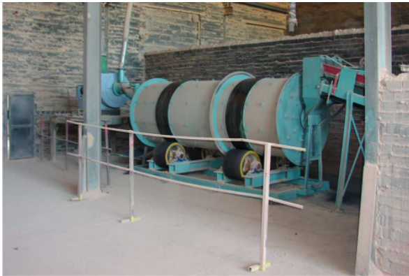
Imagen 3. Preparación de la mezcla base (vía húmeda)
