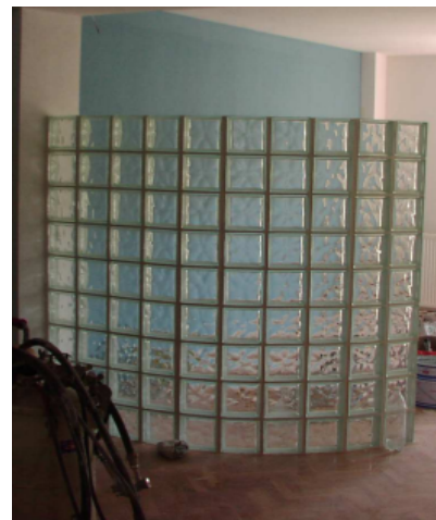
Imagen 45. Vidrio Moldeado: Bloque de vidrio ("Pavés")
