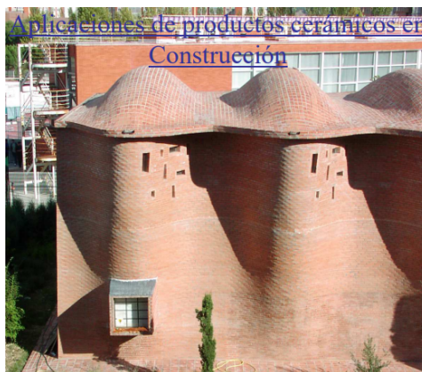
Imagen 26. Ejemplo de aplicaciones de productos cerámicos en una construcción
