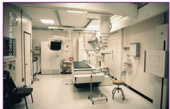
Imagen 1. Las instalaciones forman parte de los recursos materiales de una organización
